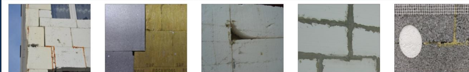
G6 - Wadliwie wykonana warstwa zbrojona
