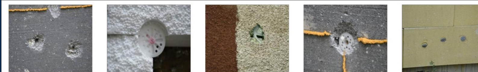
G4 - Nieprawidłowe przygotowanie powierzchni izolacji termicznej
