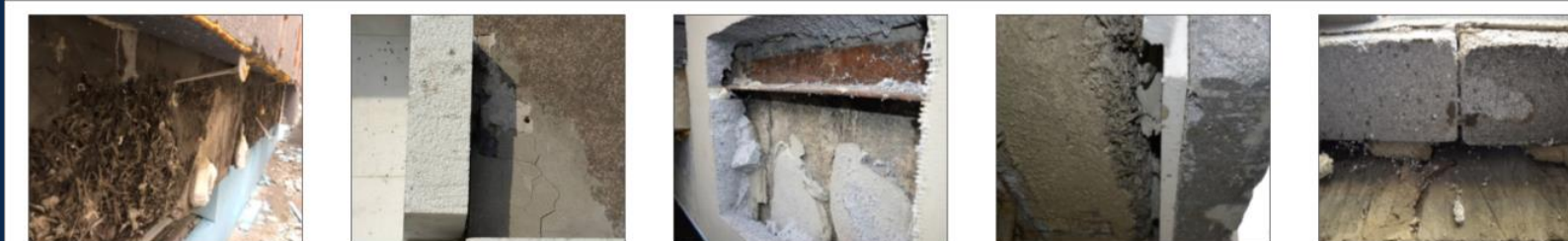
G2 - Wadliwe klejenie termoizolacji do podłoża ściennego
