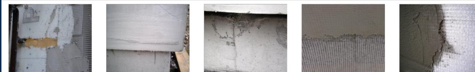
G7 - Nieprawidłowe wykonanie warstwy szpempnej i tynkarskiej
