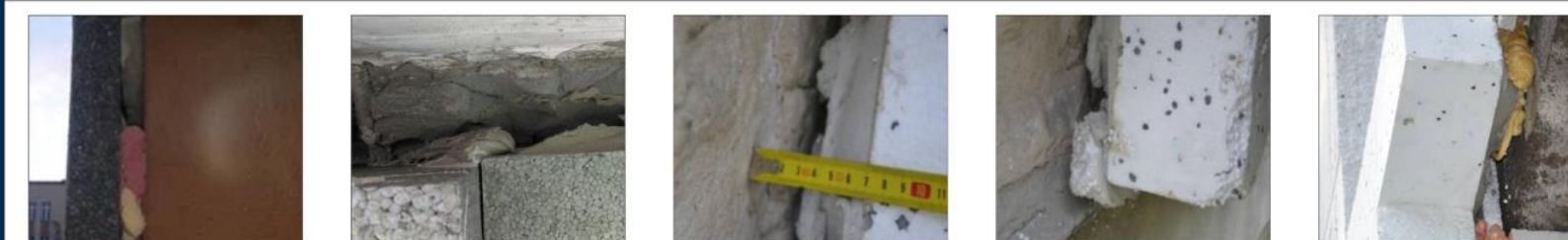
G3 - Wadliwe mocowanie mechaniczne termoizolacji do podłoża ściennego
