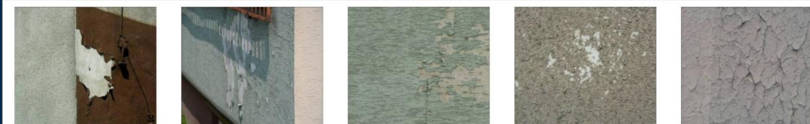
G7 - Nieprawidłowe wykonanie warstwy szpempnej i tynkarskiej
